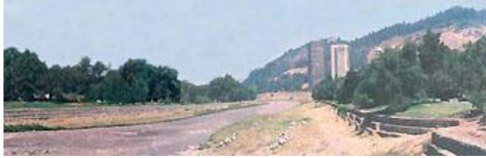
Río Mapocho antes de la intervención de la Costanera Norte.
