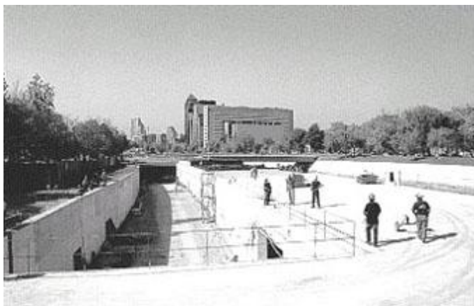
Nuevo Río Mapocho, Santiago de Chile, en construcción.
