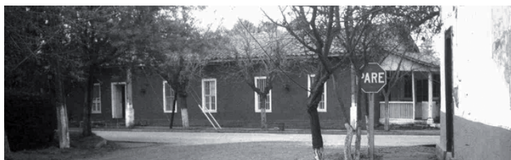
Foto 5: Casa Típica del poblado, conformando fachada continúa
