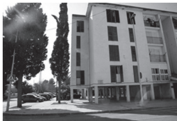
FIGURA 3. VIVIENDAS SOCIALES DEL BARRIO DE SAN FERNANDO, LORCA, ANTES DE SU DEMOLICIÓN.
