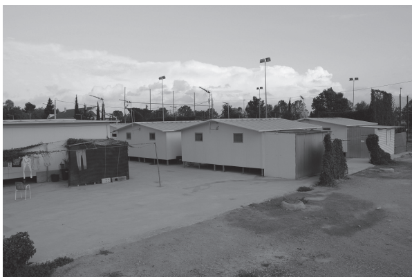
FIGURA 4. VISTA GENERAL DE LAS VIVIENDAS DE LA CRE EN LORCA.
