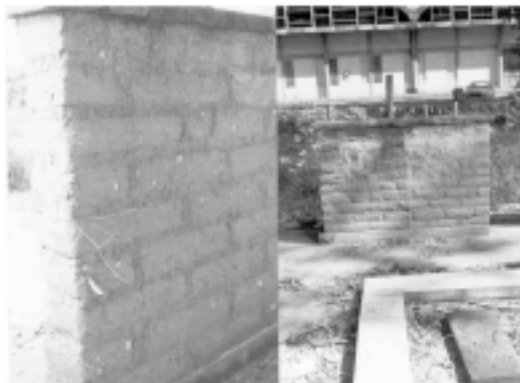
FIGURA 1: MUROS DE ADOBE SIN PROTECCIÓN SUPERFICIAL SOMETIDOS AL DESGASTE CLIMÁTICO EN DIVERSAS ORIENTACIONES. FAU UNT, TUCUMÁN.
