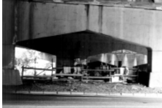
VIVIENDA BAJO PUENTE HORACIO TORO, AVENIDA REGIONAL, MEDELLÍN, 2003. (FOTOGRAFÍA: M. C. ECHEVERRÍA, CEHAP, UNAL).
