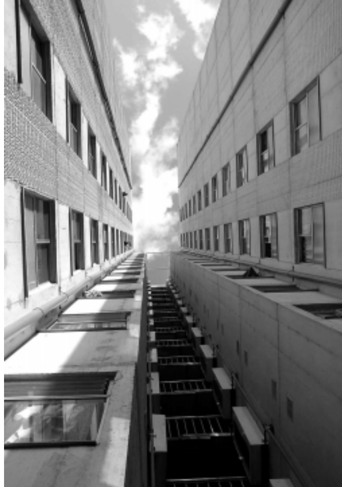
RENTA URBANA CONGELADA DE POR VIDA, INHIBITORIA DE PROCESOS DE CONFIGURACIÓN DE TRAMAS ECONÓMICAS DE SUS HABITANTES E INHÁBIL PARA PROCESOS EVOLUTIVOS. DENSIFICACIÓN DEL ALTURA, VIVIENDA DE "INTERÉS SOCIAL," MEDELLÍN, 1994. (FOTOGRAFÍA: L. F. GONZÁLEZ, CEHAP, UNAL).
