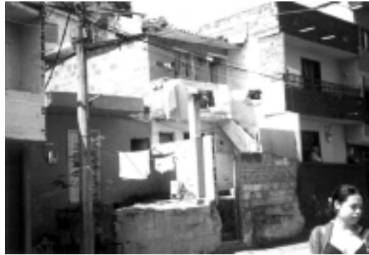
SISTEMAS ESPACIALES FLEXIBLES Y CAMBIANTES, ASOCIADOS A LAS PRÁCTICAS PARTICULARES PROPIAS DE LAS DISTINTAS FORMAS DE HABITAR. BARRIO CAUNCES 1, CENTRO ORIENTE DE MEDELLÍN, 2002. (FOTOGRAFÍA: M. C. ECHEVERRÍA, CEHAP, UNAL).
