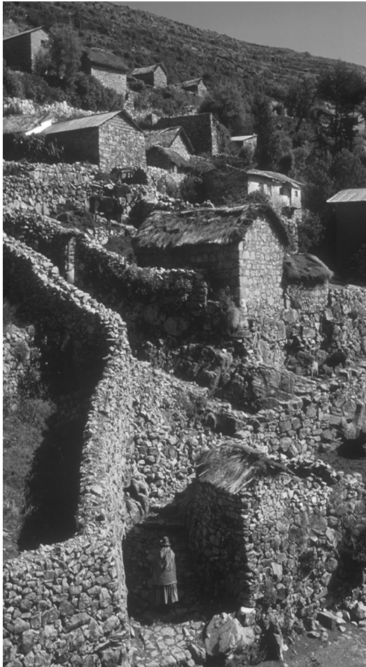
Pueblo ubicado en el área rural, próximo a la provincia de Capinota, en el Departamento de Cochabamba. Las poblaciones carecen de servicios de electricidad, transporte, agua y alcantarillado.
