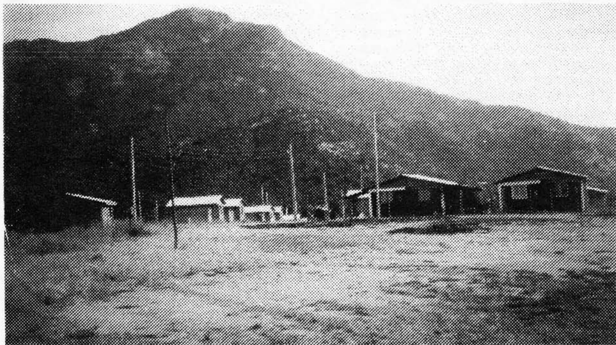
Solución de Viviendas Progresivas aisladas en asentamiento Violeta Parra (Comuna San Francisco de Mostazal, VI Región). Primera etapa de 33 mts 2 .
