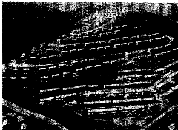
Ejemplo de una localización inadecuada
