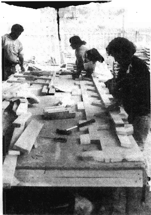
Faenas de prefabricación en obras
