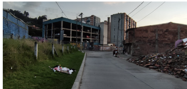
Figura 2. El Recodo y escombros. Fuente: Milena Rincón (2021).
