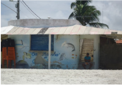
Fig. 9. Muro de contenção na Praia do Pilar.
