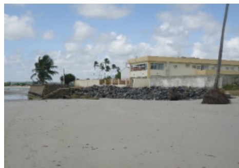
Fig. 4. Enrocamento construído à revelia na Praia do Forte Orange.
