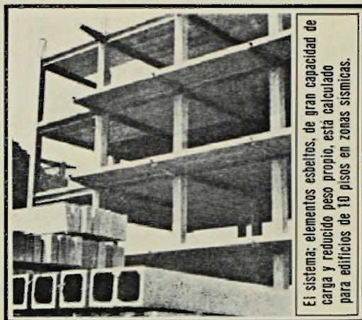
El sistema: elementos esbeltos, de gran capacidad de carga y reducido peso propio, está calculado para edificios de 10 pisos en zonas sísmicas.
