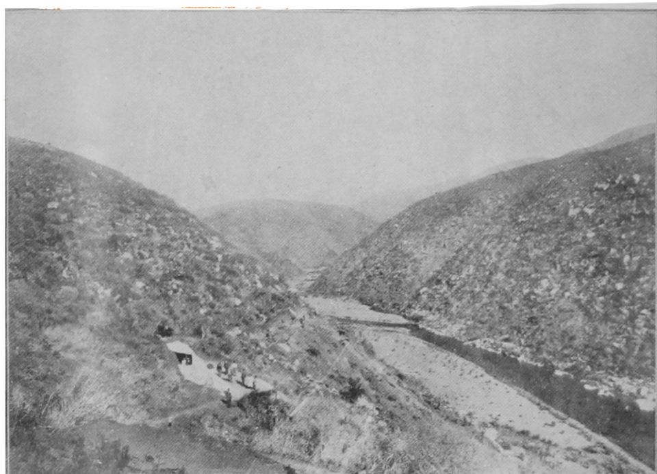
CAMINO DE ILLAPEL A MINCHA PERIODO DE CONSTRUCCION
