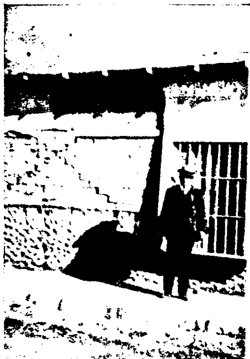
N.º 29 Copiapó.--Grieta característica en una casa
