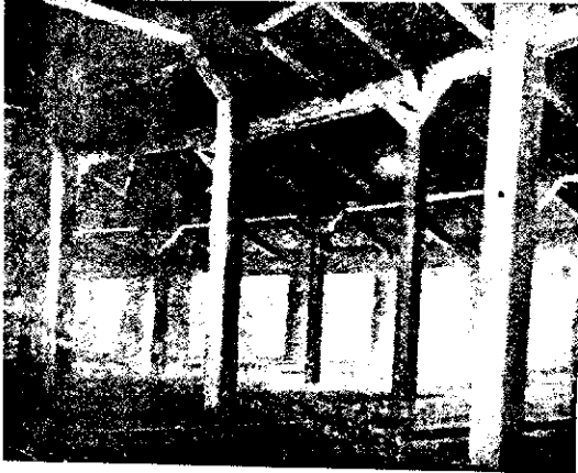
Casa de Máquinas del Eign Joliet and Eastern Railroad. Interior de la Casa de Máquinas.
