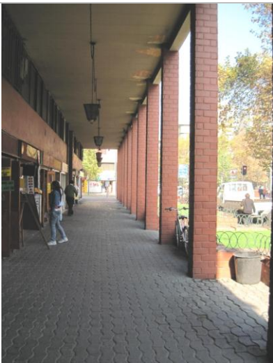
Portal en manzana al oriente de plazuela Santa Ana, en 2011.
