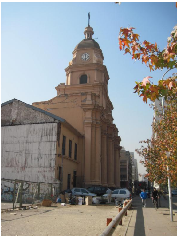
Daños en la Iglesia Santa Ana luego del terremoto de febrero de 2010, en 2011. (El predio al poniente a la Iglesia (2.365m 2 permanece ineditado, pues la altura de edificación exigida debe ser inferior a la altura de la torre).
